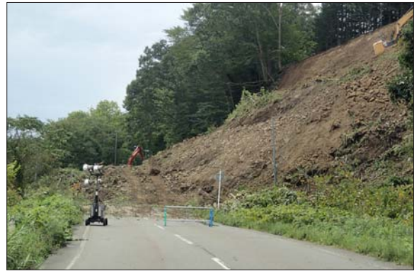
土砂崩れにより通行止めになった道道351号（庫富）
