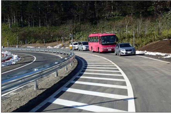
復旧現場を視察するバスツアー
