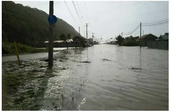
高潮により冠水した清島市街地
